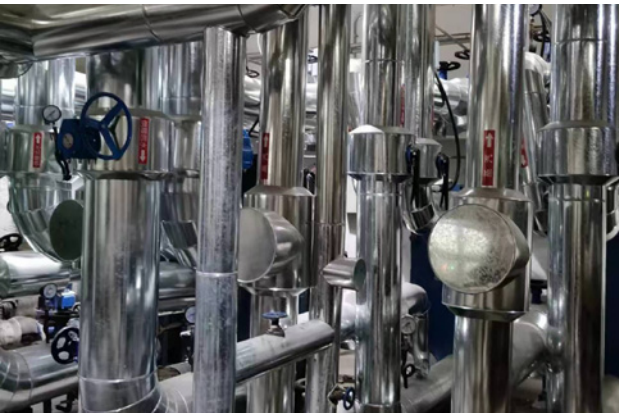
更換供熱閥門
